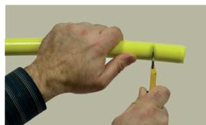
Dénudez votre tuyau IZINOX® à l'aide d'un cutter (10 ondulations soit environ 5 cm).
