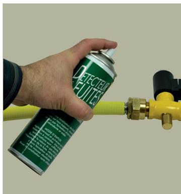
Une fois tous les éléments de l'installation gaz raccordés, procéder à la vérification de l'étanchéité à l'aide de l'aérosol de détection de fuite Gurtner (réf. 14711) ; La pression de contrôle doit se faire en fonction de la mise en œuvre. Elle est définie dans le DTU 61.1 P3 (voir page 35)
